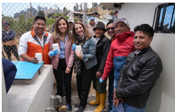
Pie de foto: Implementación de Cloradores en la comunidad Bramadero Chico
